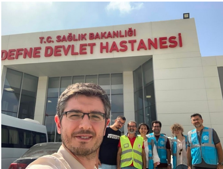
10: Defne Hastanesi Ana Bina Girişi
